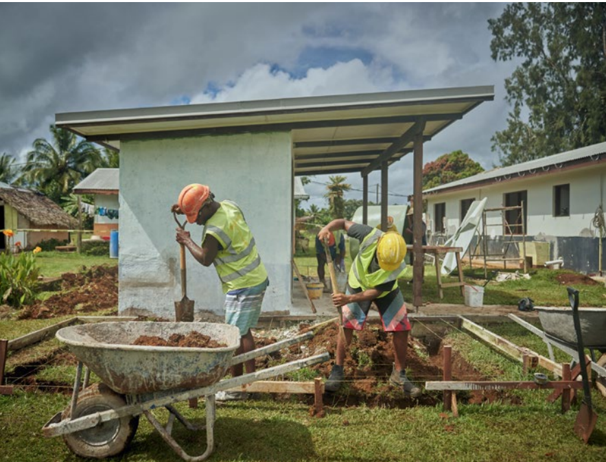
世卫组织支持各项通过改善整个太平洋地区的医疗卫生设施来提升气候韧性的项目。图为2025年10月拍摄的瓦努阿图法纳福卫生中心（Fanafo Health Centre），设施升级改善了水质和卫生条件，使其更加安全并能更好地抵御极端天气，确保即使在灾害来袭时护理服务也不会中断。
